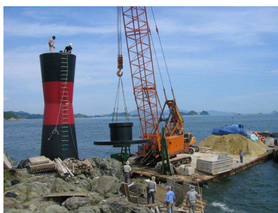
<그림4-6> 항로표지(등표) 설치공사
