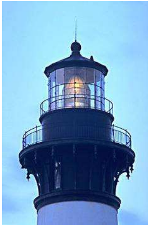
<그림2-21> Bodie Island 등대, 미국 <그림2-22> 등명기의 전형적인 형태인 프레즈넬렌즈 11)
