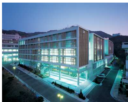
<그림 3-20> 서울대학원 연구동의 표피 - 좌, 우로 이동 가능한 외부루버는 행위를 통해 입면의 변화 가능성을 의미한다.
