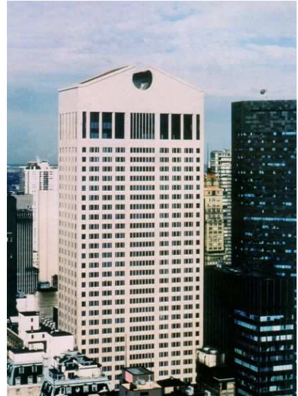
<그림 3-13> AT&T건물 - 석재마감에 창문을 뚫고, 상부부분에 세로창과 페디먼트를 통해 고전건축물의 특성을 재현하고 있다.
