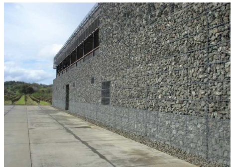
<그림 3-6> 서측 입면 - 가까이에서 와 인저장고의 외벽은 콘크리트가 아닌 쇠석의 적층으로 구축되고 있음을 확인할 수 있다.
