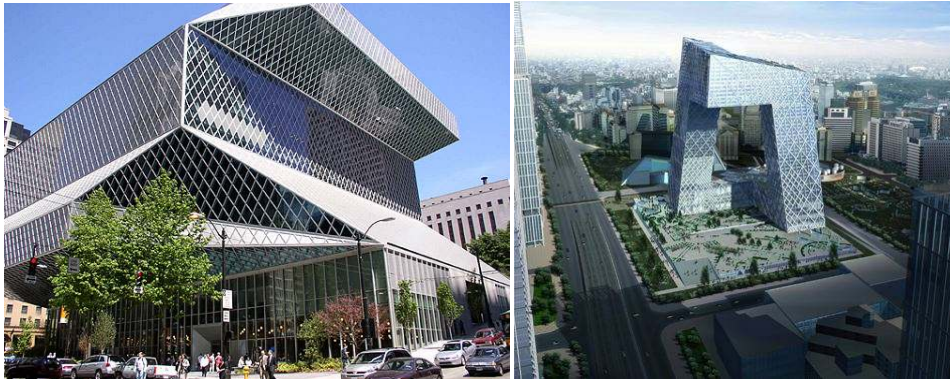
그림 3.42 램 콜하스(OMA)- 시애틀 공공 도서관, CCTV Headquater
